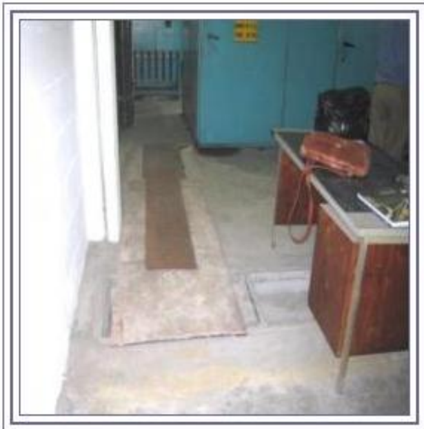
ABERTURA DE CANALETAS E INSTALAR CUBÍCULOS DE MÉDIA TENSÃO IP40 , 15 KV, 20KA, ISOLAÇÃO SF6
