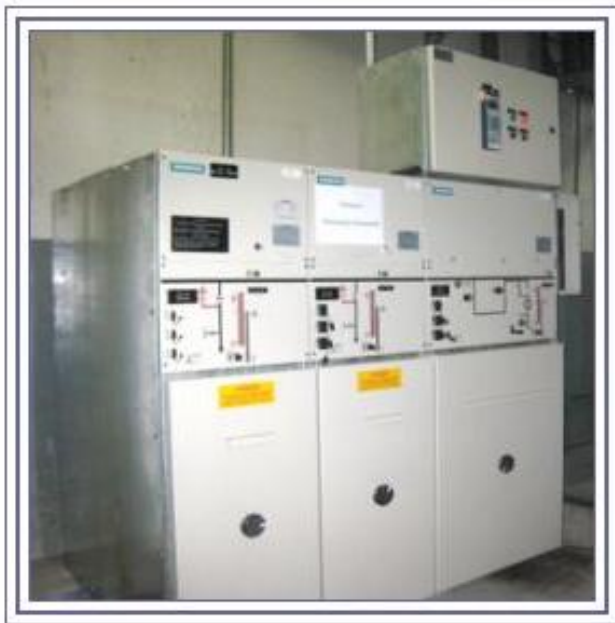
ABERTURA DE CANALETAS E INSTALAR CUBÍCULOS DE MÉDIA TENSÃO IP40 , 15 KV, 20KA, ISOLAÇÃO SF6
