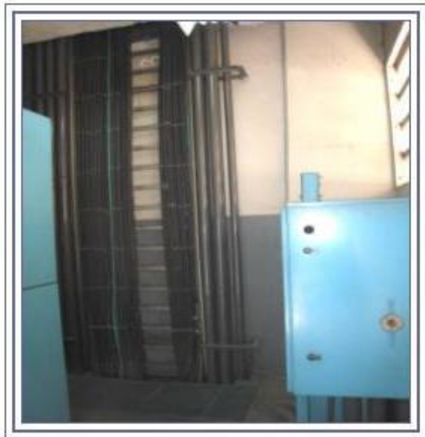
RETIRADA DO QUADRO DE CORREÇÃO F. POTENCIA ANTIGA, E REINSTALAR COM QUADRO AUTOMATICO DE CORREÇÃO 300 KVAR , PADRAO TTA , COM SISTEMA DE FILTROS DE HARMONICAS E AVISO DE ALARME SONORO E LUMINOSO
