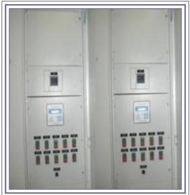
RETIRADA DO QUADRO DE CORREÇÃO F. POTENCIA ANTIGA, E REINSTALAR COM QUADRO AUTOMATICO DE CORREÇÃO 300 KVAR , PADRAO TTA , COM SISTEMA DE FILTROS DE HARMONICAS E AVISO DE ALARME SONORO E LUMINOSO
